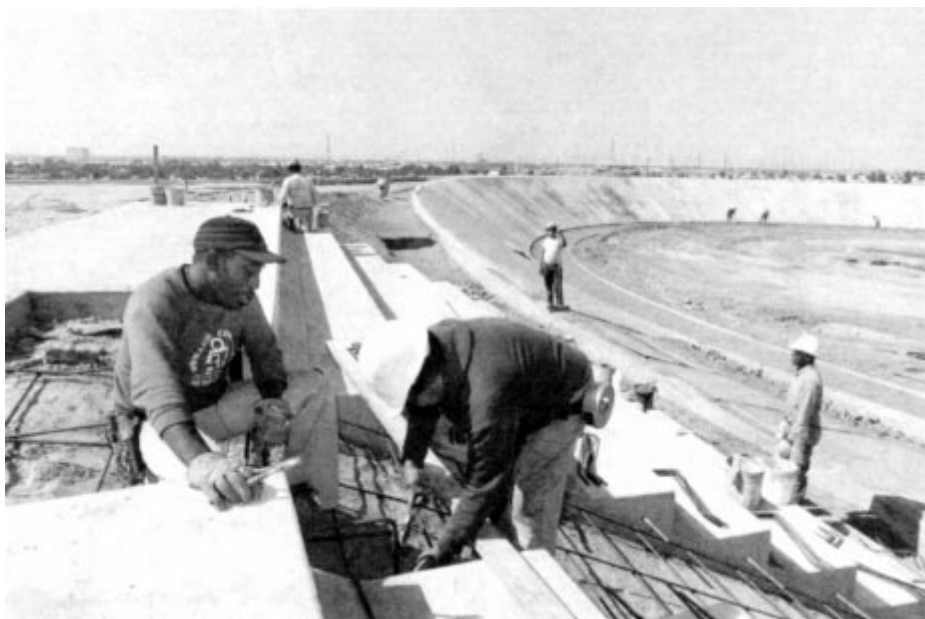
Le vélodrome olympique en construction...
